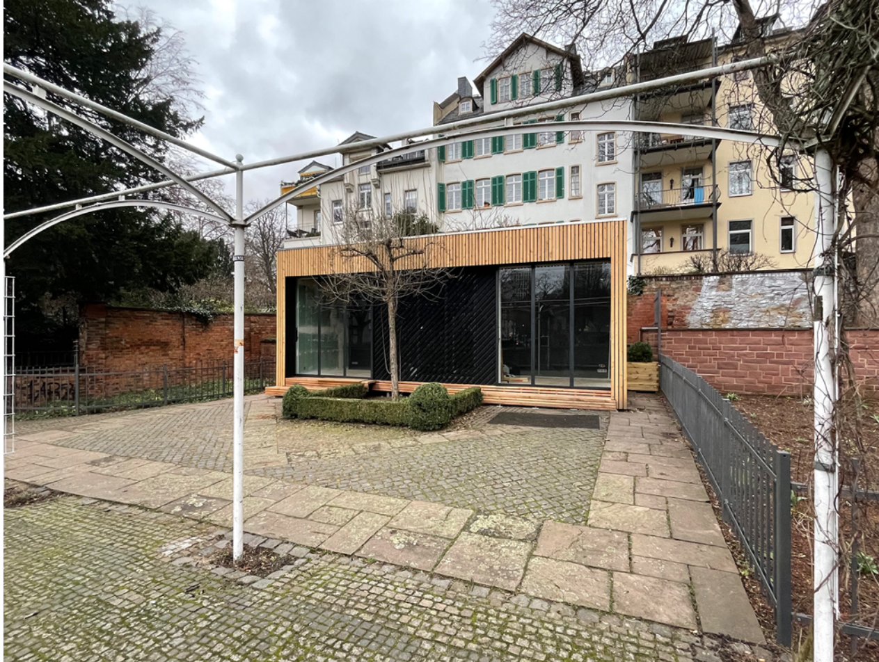
aussenansicht saasfee*satellit (bild: bauphase) Tiefgarten saasfee*pavillon / frankfurt main
